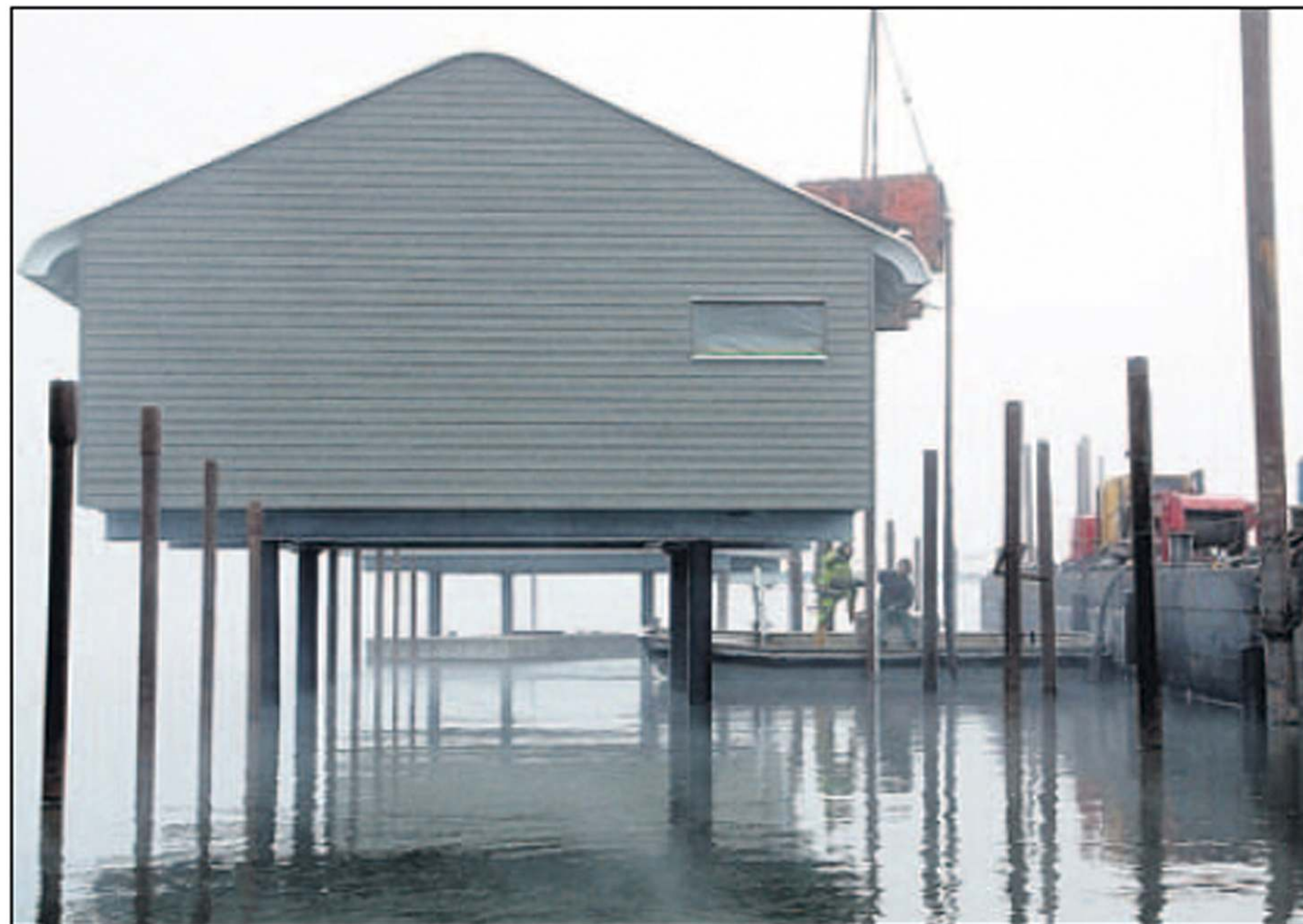
Es ist geschafft: Die ersten zwei Apartmenthäuser stehen auf ihren Stelzen im Rügischen Bodden in der Marina „Im Jaich“.
